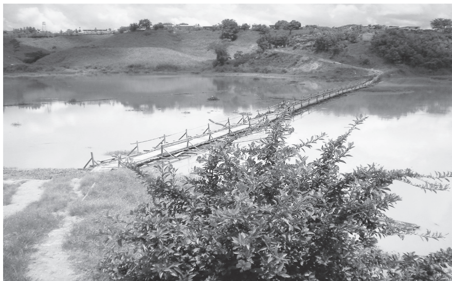
Foto 8. Puente flotante sobre un brazo del embalse, sector El Mate. Fuente: fotografía de Jimmy Pérez.
