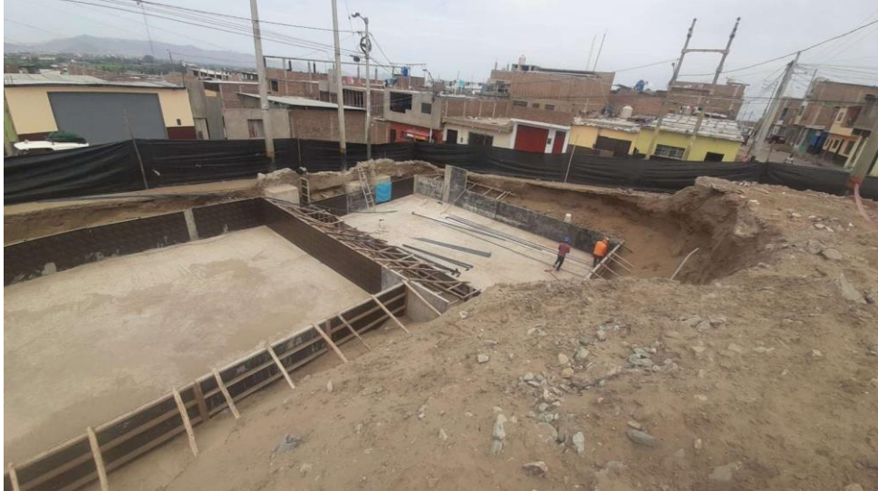
Platea de cimentación del Pabellón N°01
