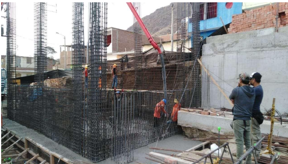
Acero en muros de concreto y placas del Pabellón N°01
