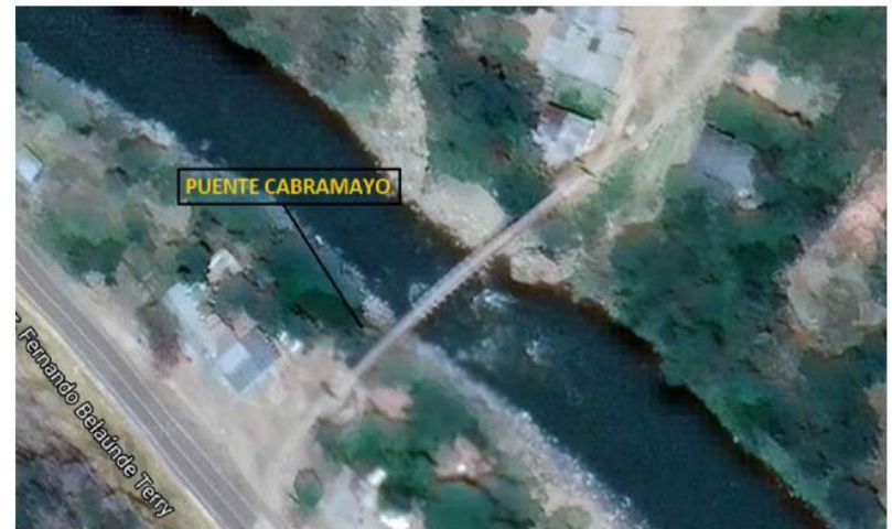
UBICACION DEL PUENTE CABRAMAYO
