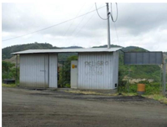
Ilustración 24: Área donde se ubica el generador
