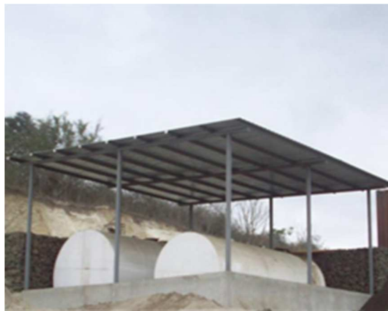
Ilustración 23: Área para combustible
