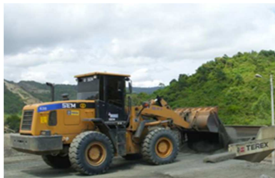
Ilustración 16: Transporte del material hacia las tolvas de alimentación
