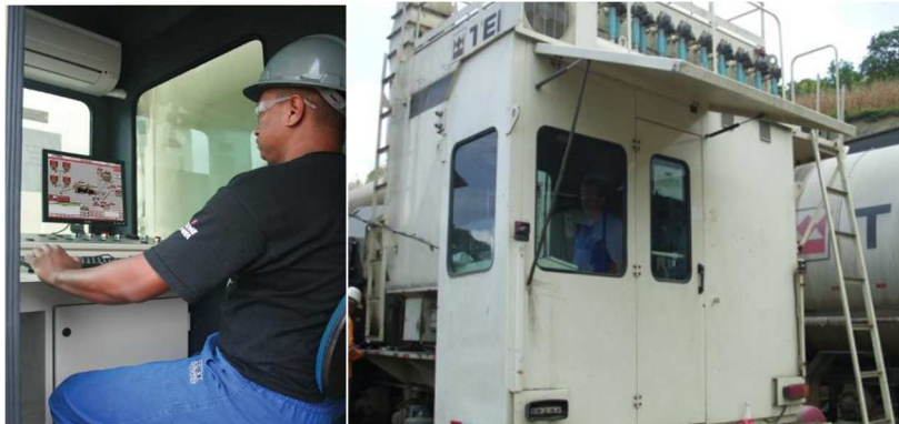
Ilustración 13: Cabina de control de la planta
