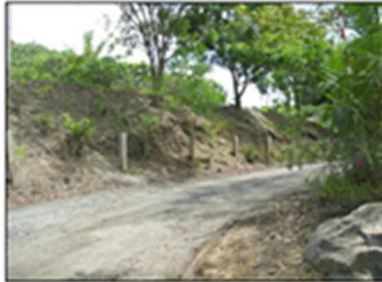
Ilustración 5: Acceso a la Planta de Asfalto Ciudad Rodrigo, coordenadas PSAD 56: 550016E - 9887654N
