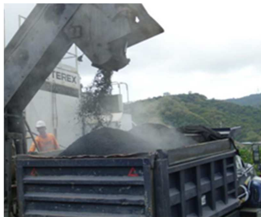
Ilustración 18: carga de mezcla asfáltica
