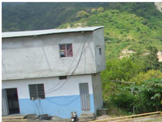
Ilustración 22: Oficina e instalaciones para guardiana
