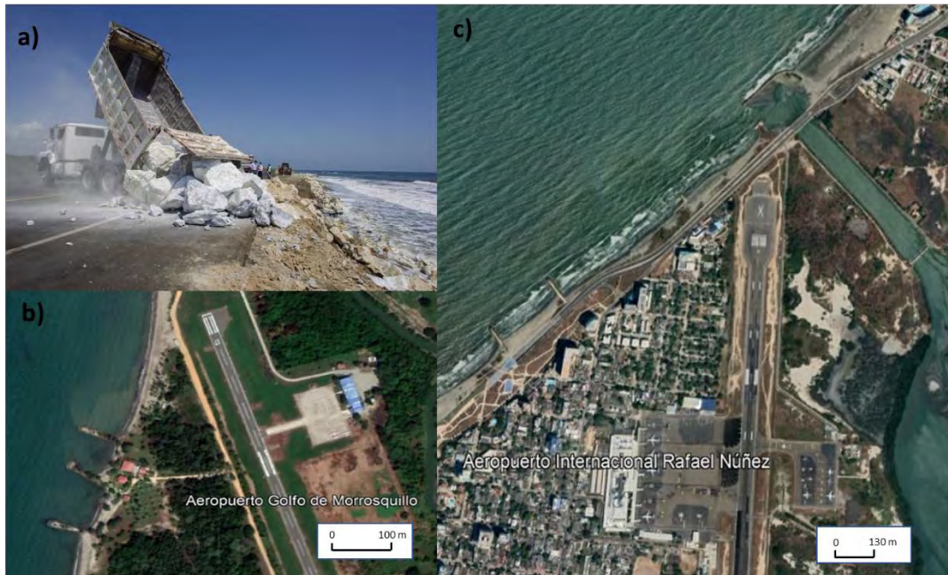
Figura 6-1. Infraestructuras estratégicas en riesgo. a) Carretera troncal del caribe km 19 vía Barranquilla-Ciénaga (El Tiempo, 2021). b). Aeropuerto Golfo de Morrosquillo (Tolú-Sucre). c) Aeropuerto Internacional Rafael Núñez (Cartagena-Bolívar).
