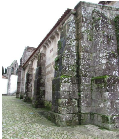
Figura 16 - Pormenor do contraforte românico, Igreja de São Pedro de Rates – (Imagem do autor.)
