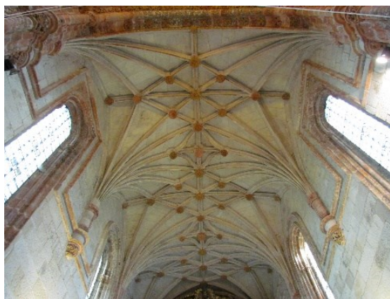
Figura 28 - Pormenor do teto – (Imagem do autor)
