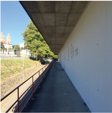
Fig. 34 Corredor lateral a la calle y vista a la vía del metro Fotografía propia
