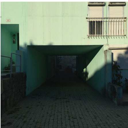
Fig. 25 Paso hacia la zona trasera de las viviendas Fotografía propia
