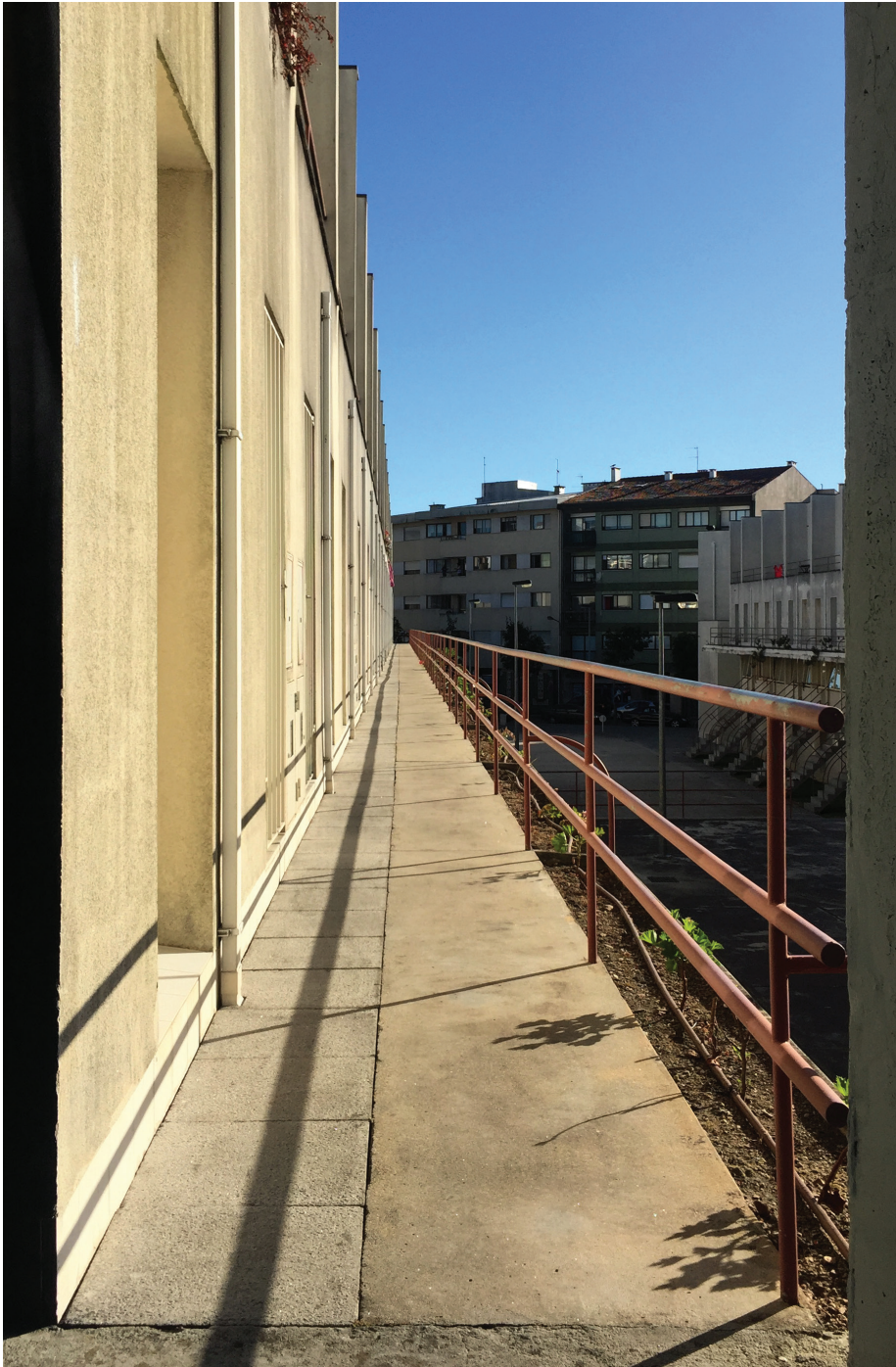
Fig. 32 Corredor de acceso a las viviendas superiores Fotografía propia
