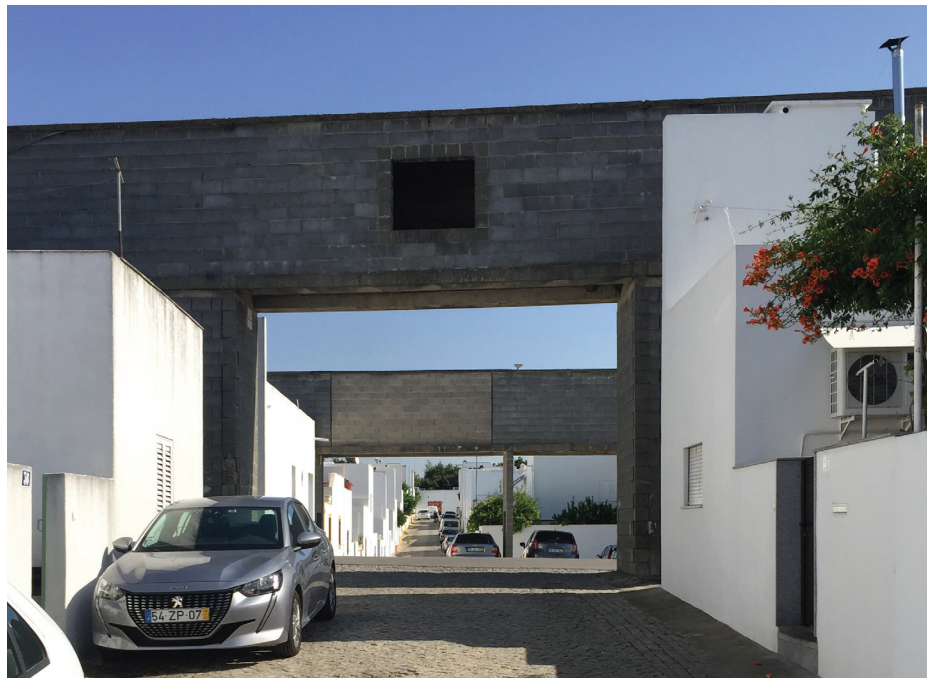
Fig. 52 La conduta como segunda escala (monumental) Fotografía propia
