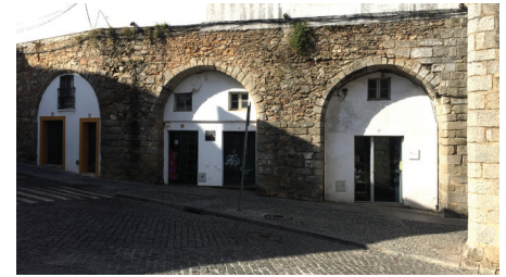
Fig. 47 Acueducto sobre los locales y viviendas en la ciudad histórica Fotografía propia
