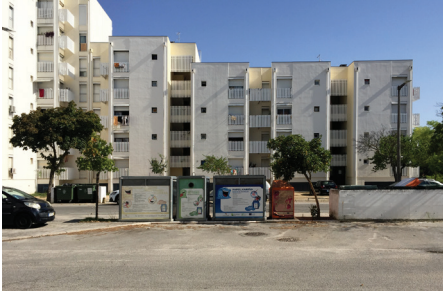
Fig. 45 y 46 Bloques cruciformes proyectados para el crecimiento de la ciudad. Finalmente sólo fueron construidos 4 Fotografía propia
