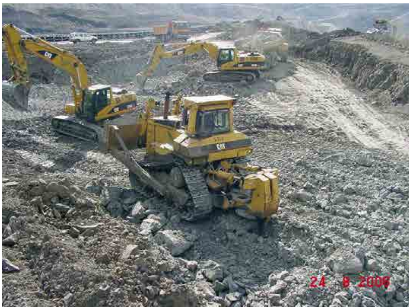
Extracción de arcillas cerámicas. En ocasiones fue necesario ripar el material con bulldozer debido a su gran dureza, 2006
