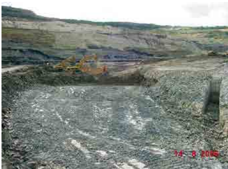
Excavadoras convencionales limpiando el nivel productivo, 2006
