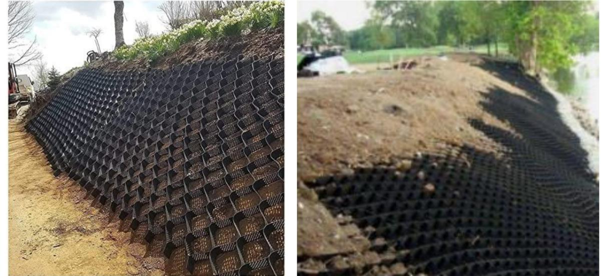
*Ejemplos de geocelda instalada en talud*
