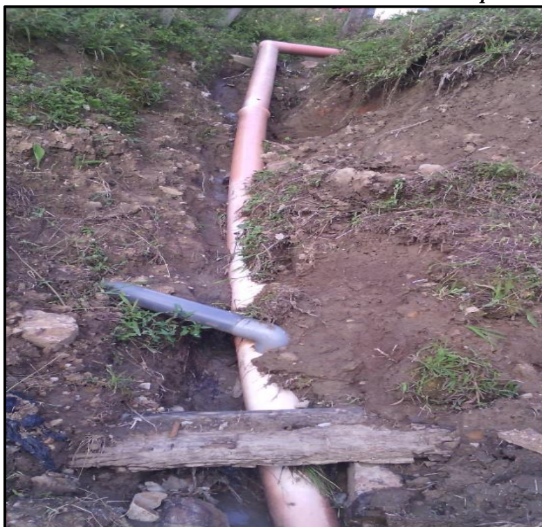
FOTOGRAFÍA 5: Redes de alcantarillado a la intemperie
