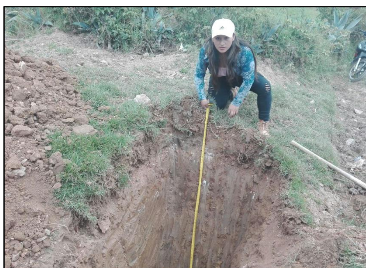
FOTOGRAFÍA 23: Calicata n°07 a 1.60 metros de profundidad
