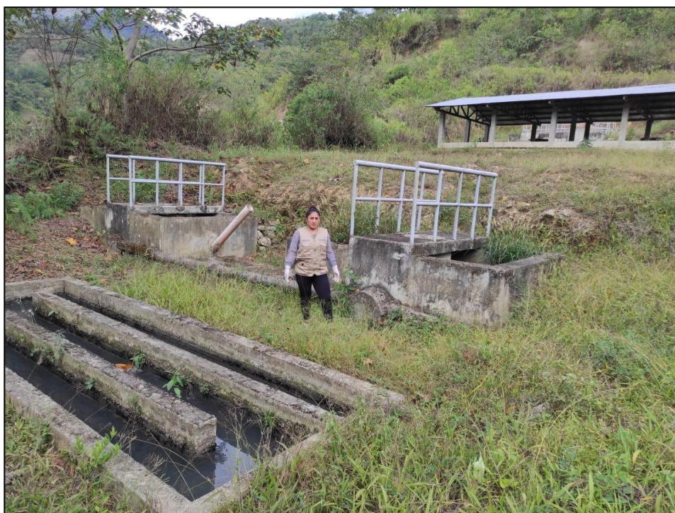
Fotografía 6.13: Inspección de la PTAR del distrito.
