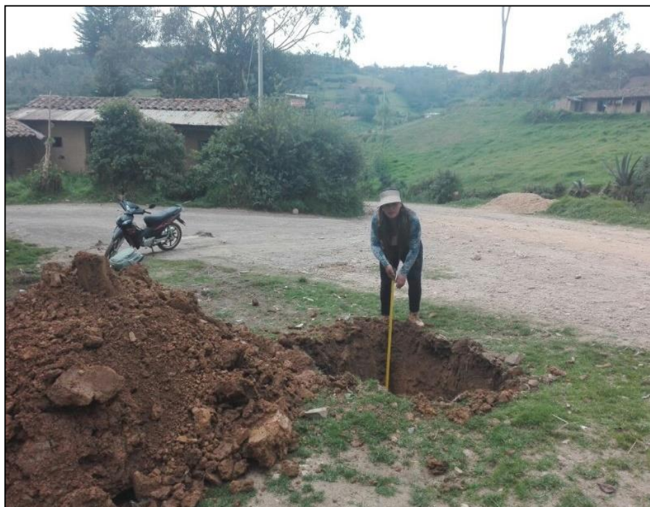
Fotografía 6.9: calicata N° 15, profundidad 1.60m.
