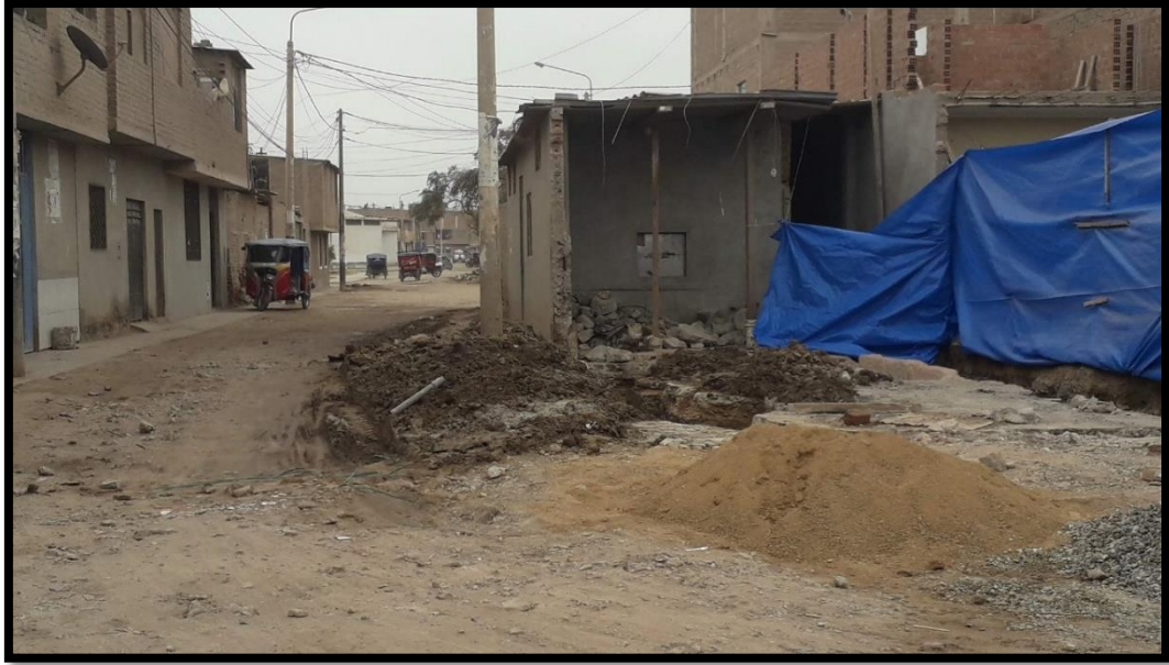
Ilustración 36. Cambio de tubería de agua potable por parte de un poblador
