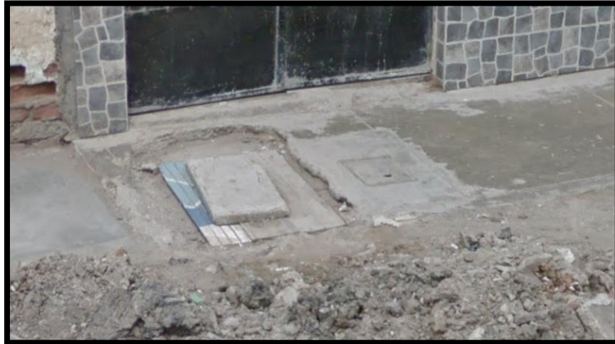
Ilustración 47. Conexión Domiciliaria de Alcantarillado con Tapa provisional de Madera
