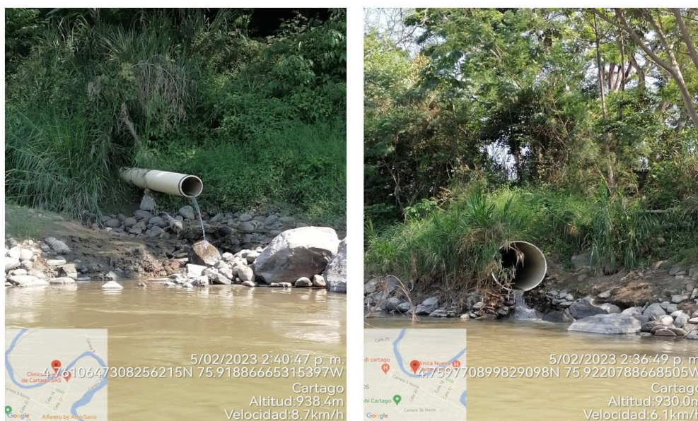
Figura 38. Contaminación del río La Vieja, la quebrada Ortes y la madre vieja La Zapata por vertimientos de aguas residuales domésticas provenientes de la zona urbana del municipio de Cartago
