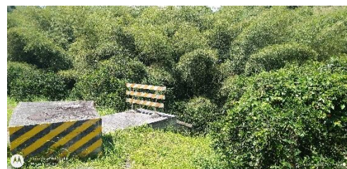
Punto 4: Es el punto donde se encuentra directamente el descole de aguas residuales domésticas de Pereira y parte de Dosquebradas
