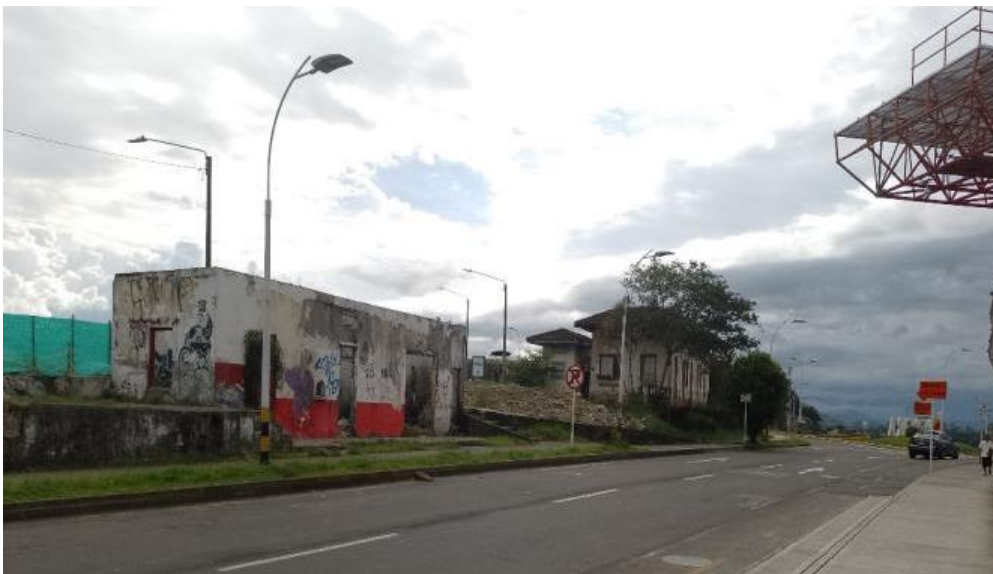
Imagen 10 Estado actual de la Estación Nacaderos (septiembre, 2022)
