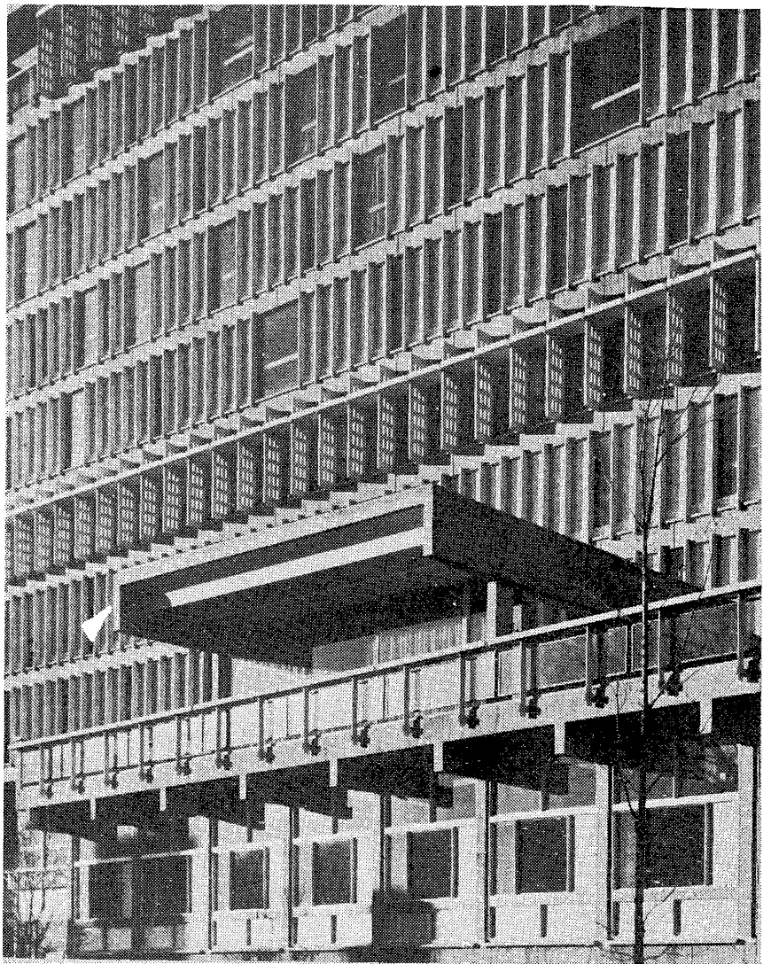
Detalle fachada sudoeste
