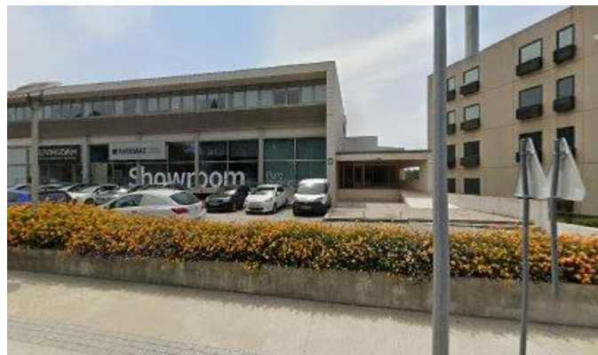
Figura 1.4 – Edifício sucursal da ATM na Maia [3]
