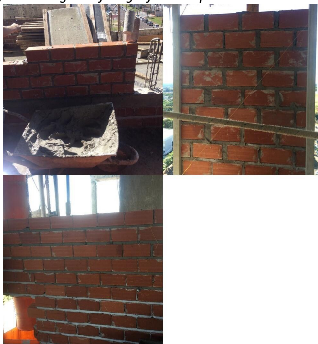
Figura 2. Registro fotográfico dos pedreiros da obra 2.
