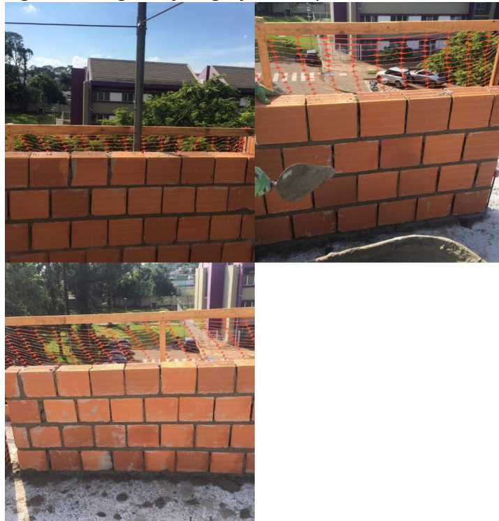
Figura 3. Registro fotográfico dos pedreiros da obra 3.
