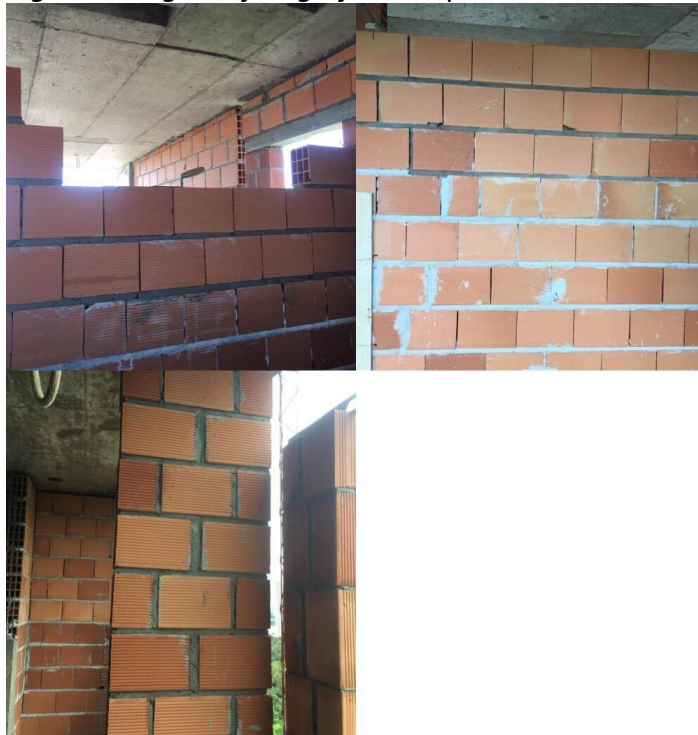
Figura 1. Registro fotográfico dos pedreiros da obra 1
