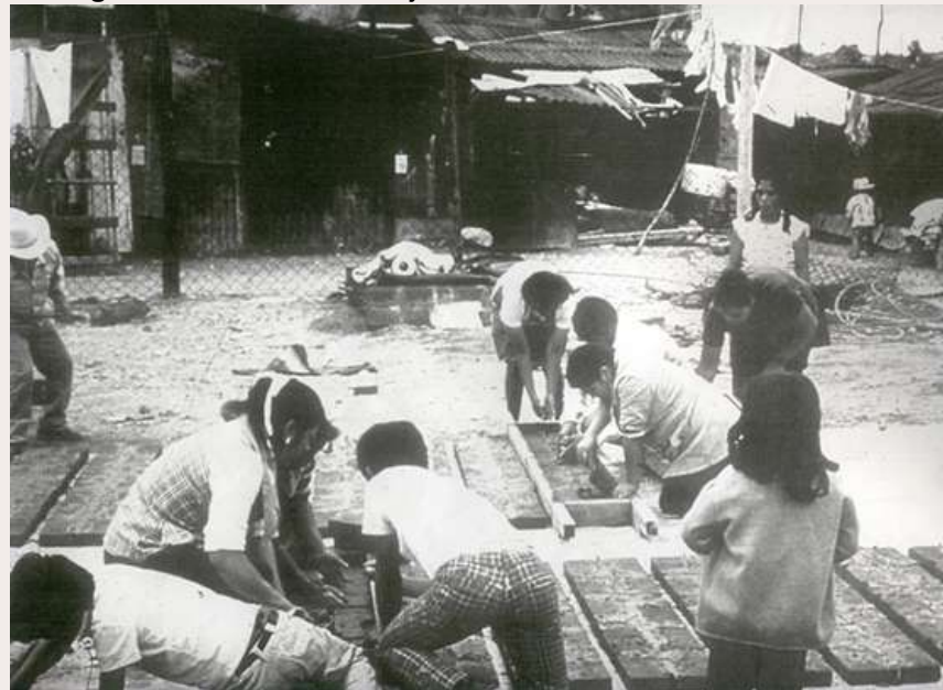
Figura 15 – Familias trabajando en la construcción de las casas
