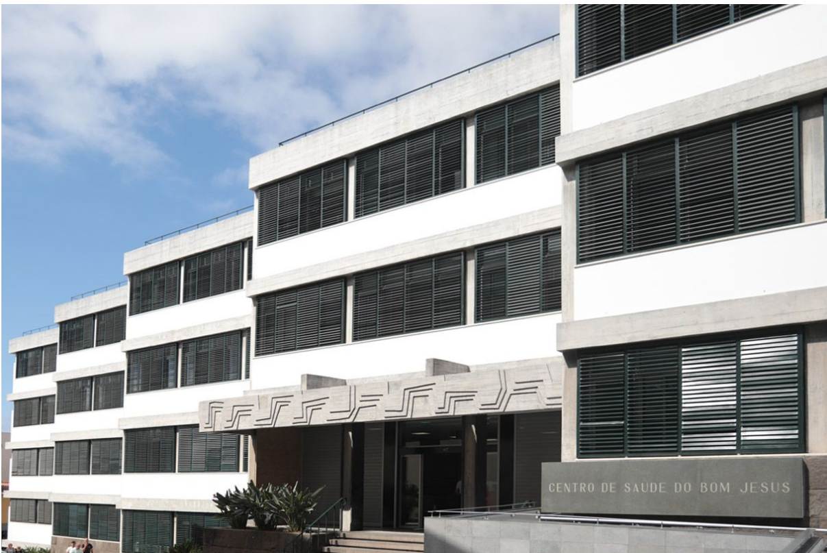
Figura 22 - Remodelação do Centro de Saúde a analisar. Fonte: RTP (2022).
