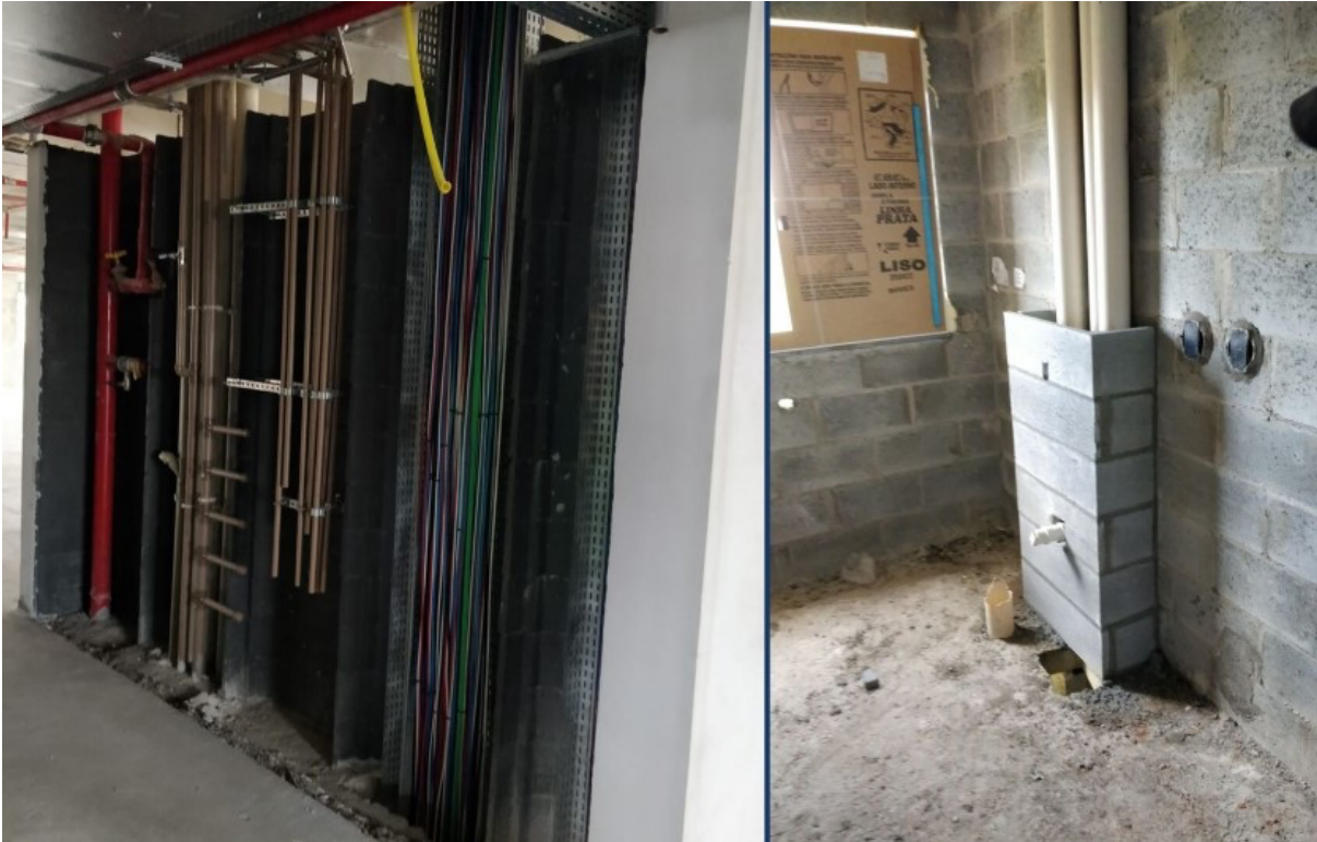
Figura 27 - Construção de shafts para a passagem de canalizações. Fonte: Thórus Engenharia (2022).
