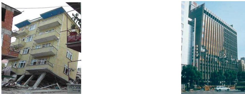
Figura 2.15 – Exemplos reais do efeito Soft Storey : (a) No R/C (Halde & Deshmukh, 2015); (b) Nos pisos superiores, sismo de Kobe 1995 (Bachmann, 2003).
