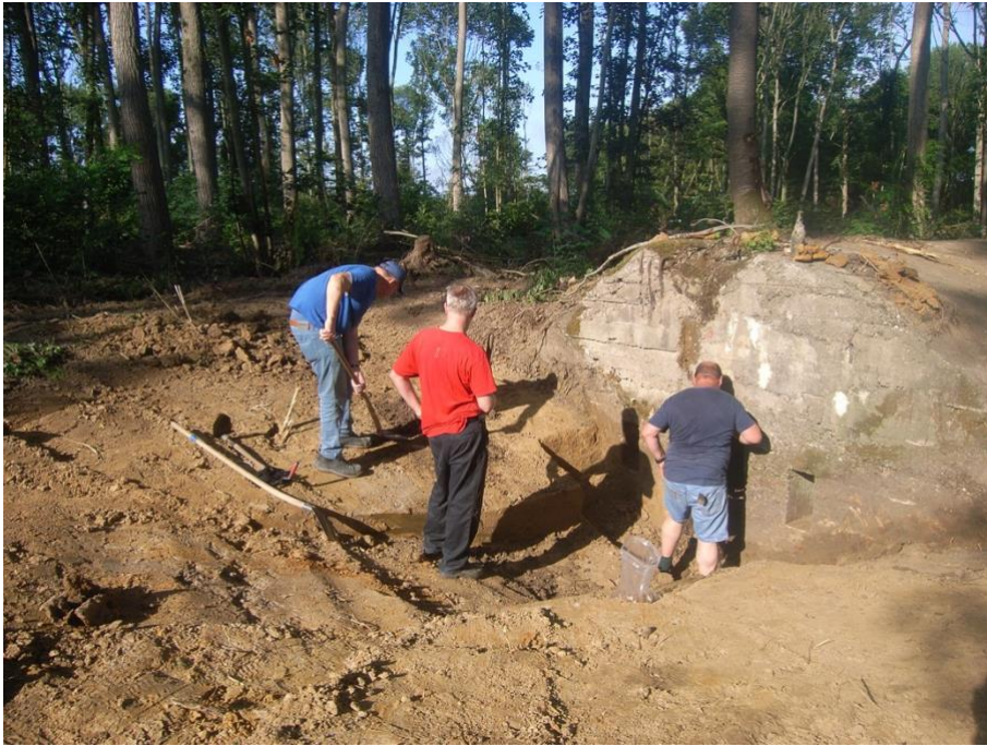
Fig. 3: Bij het vrijmaken van de ingang van bunker 2 werden WO I resten aangesneden. Ze werden over een beperkte zone verder blootgelegd om ze te kunnen interpreteren (© aOE).
