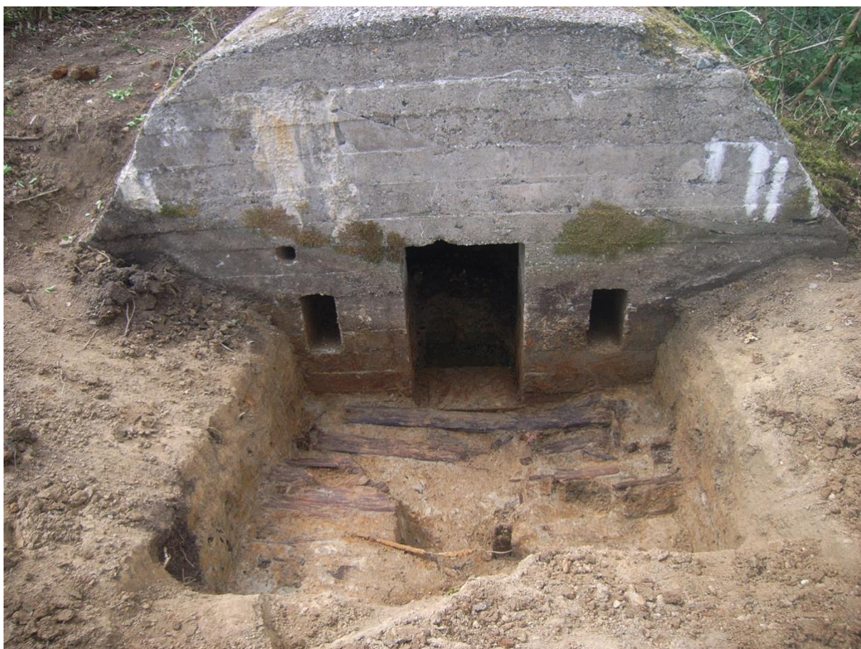
Fig. 10: Zicht op de aangetroffen resten na de eerste ingreep ter hoogte van bunker 1. Aan de voorkant van de bunker zijn planken van de loopgraaf (op de voorgrond) en van de lager gelegen overloop te zien. Hier en daar valt ook de restant van een paal op, naast een metalen buis met telefoonkabel (© aOE).
