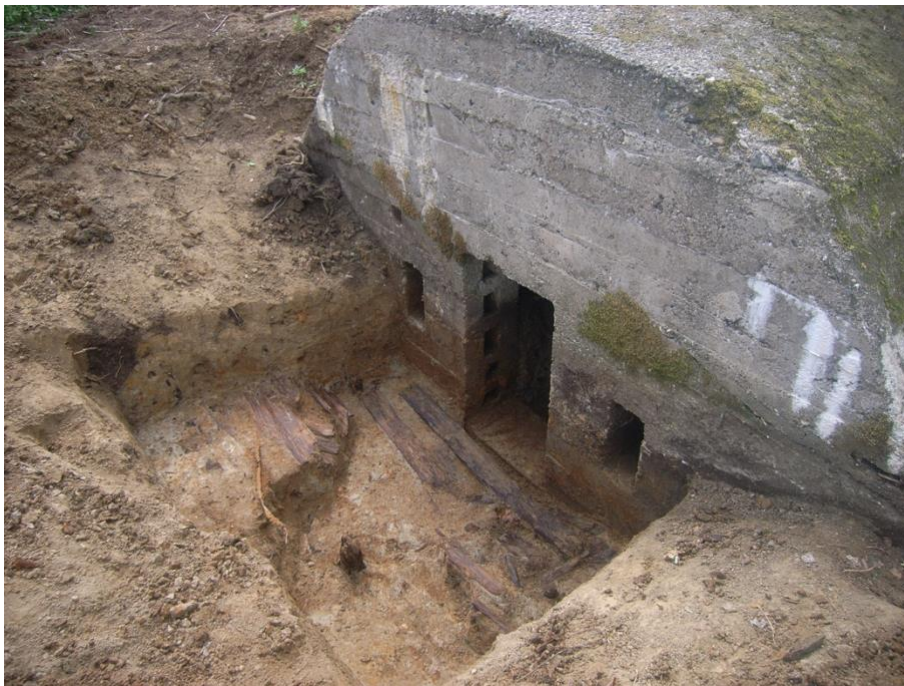
Fig. 12: Zicht vanuit het noordoosten op de aangetroffen structuren voor de ingang van bunker 1 (© aOE).
