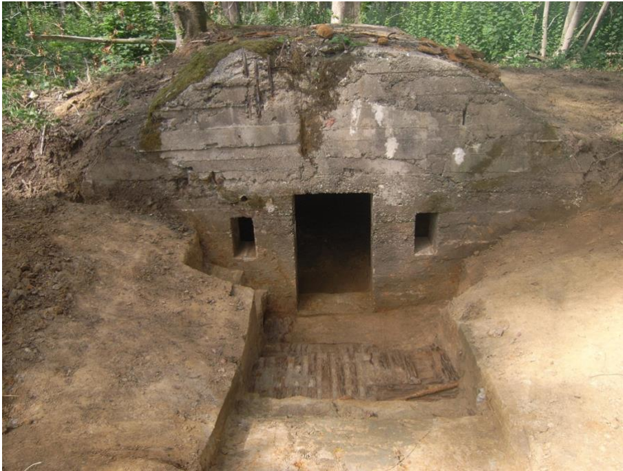
Fig. 17: Frontaal zicht op de voorzijde van de bunker 2 na de eerste ingreep (© aOE).
