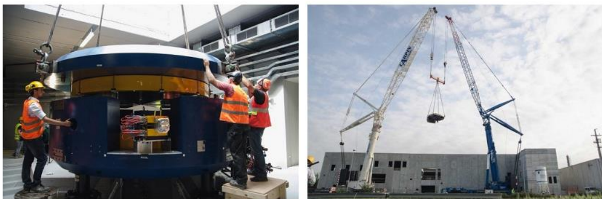
Figura 1.7. Fasi di installazione del ciclotrone presso i LNL (Maggio 2015).
