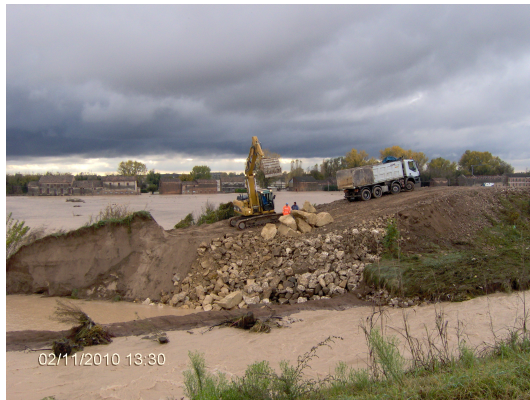
(a) Posizionamento pietrame a monte della rotta, giorno 2 novembre.
