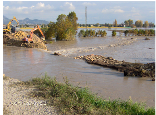
(b) Posizionamento pietrame e condizione della rotta, giorno 3 novembre.
