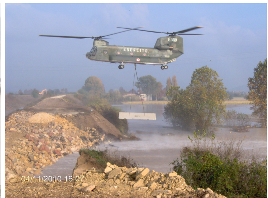
(b) Posizionamento di una delle travi in calcestruzzo armato.
