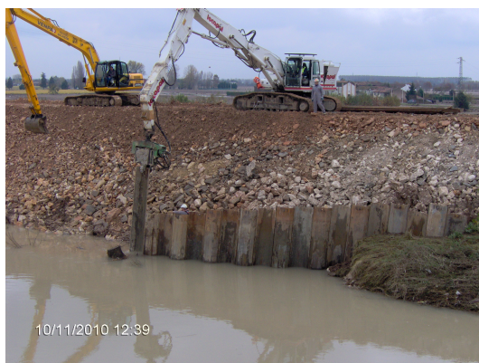
(a) Posizionamento delle palancole, giorno 11 novembre.
