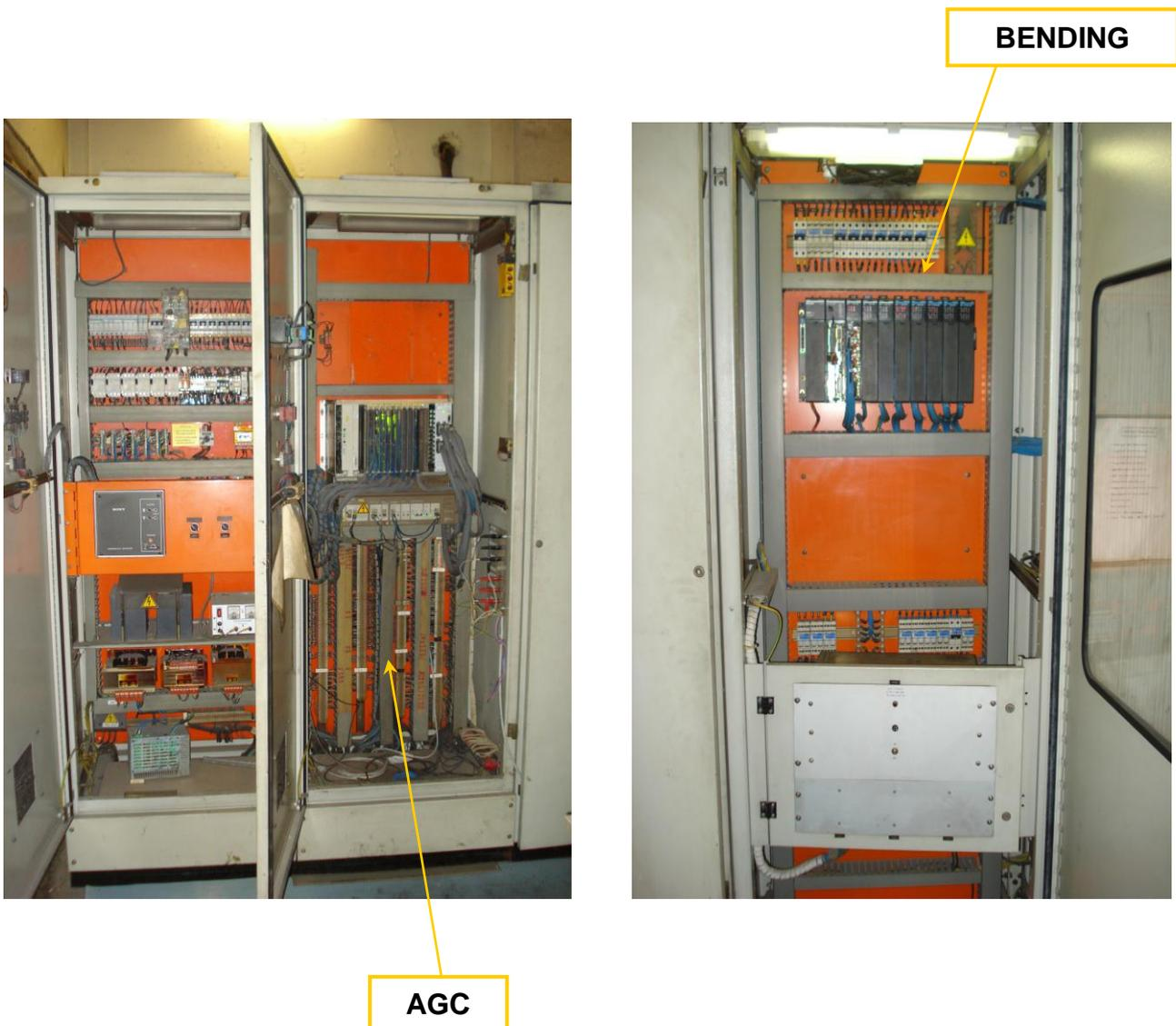
Figura 3.1: AGC e Bending presenti attualmente nel laminatoio a caldo di Fusina
