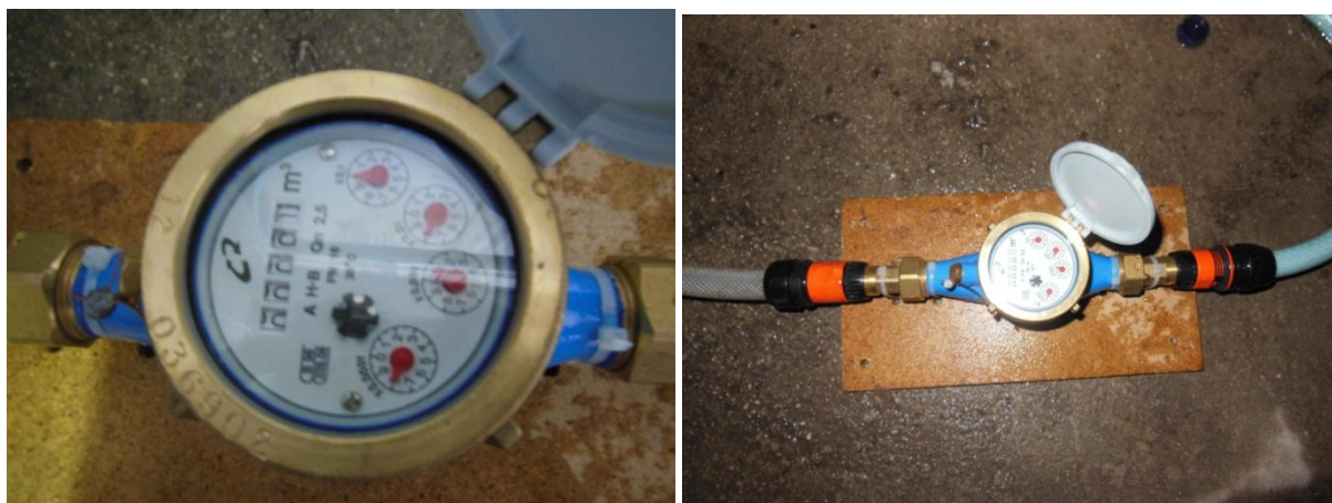
Figura 3. 416: Contaltri utilizzato per la misura dell'acqua durante le prove di verifica di perdite
