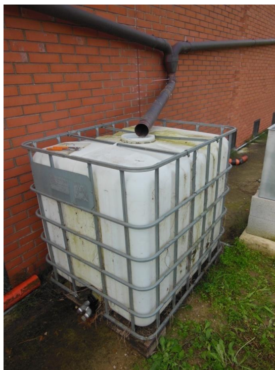
Figura 3. 427: Tanica da 500 litri utilizzata durante le prove di verifica di perdite
