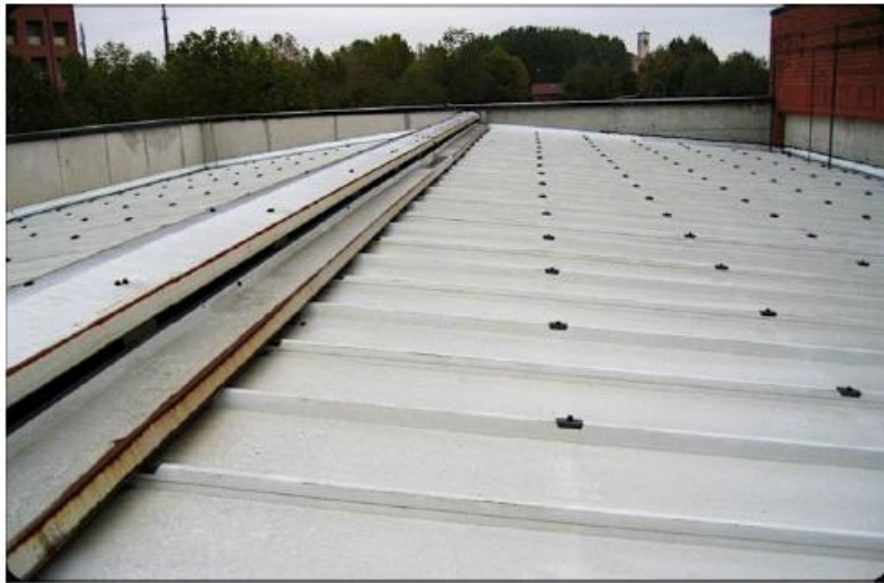
Figura 3. 4: Copertura della Centrale Tecnologica (Brusaferrò, 2012)
