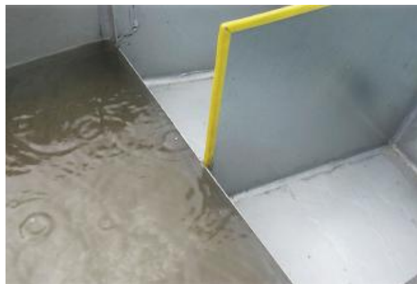
Figura 3. 372: Particolare dello stramazzo a “stracolmo”
