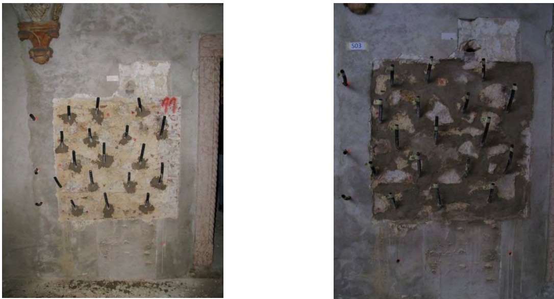
Fig. 3.2. 3 - Prime ristilatura parziale e successiva ristilatura completa dei giunti
