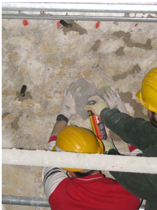
Fig. 2.4. 59 - Riempimento del foro mediante poliuretano espanso
