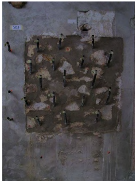
Fig. 2.4. 53 - Prima ristilatura parziale dei giunti e successiva ristilatura completa campo prova 3 (Museo Archeologico)
