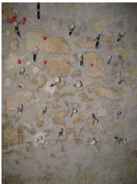
Fig. 2.4. 51 - Cannule sigillate dopo l'iniezione
