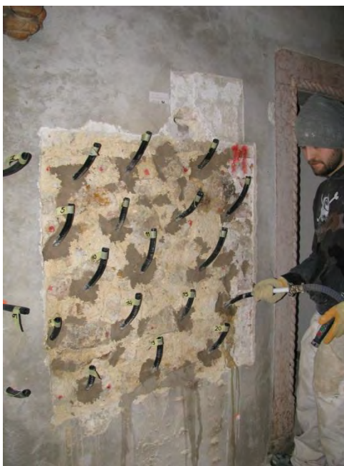
Fig. 2.4. 52 - Lavaggio del campo prova 3 (Museo Archeologico)
