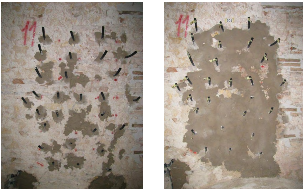
Fig. 2.4. 43 - Prima ristilatura parziale dei giunti e successiva ristilatura completa (Museo Archeologico)
