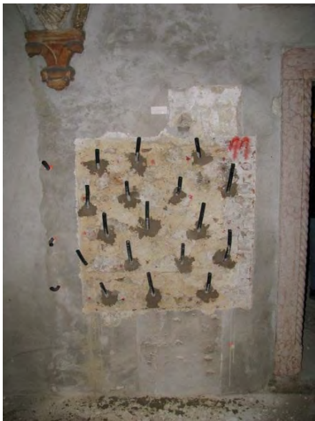
Fig. 2.4. 53 - Prima ristilatura parziale dei giunti e successiva ristilatura completa campo prova 3 (Museo Archeologico)
