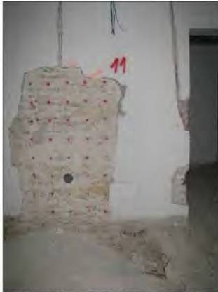
Disposizione griglia ACCELEROMETRO
