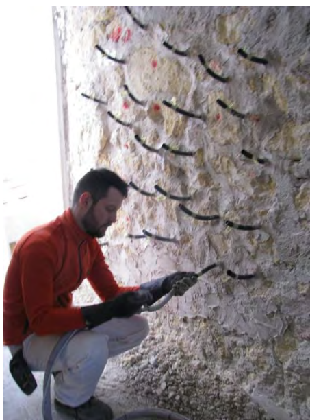
Fig 1.2. 7 - Esecuzione dell'intervento di iniezione (Museo Archeologico)
