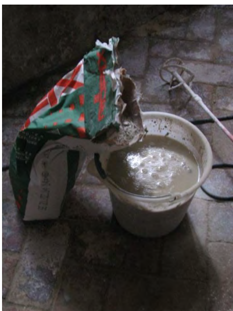
Fig. 2.4. 54 - Miscela Rofix e miscelazione mediante pompa ad immersione (Museo Archeologico)
