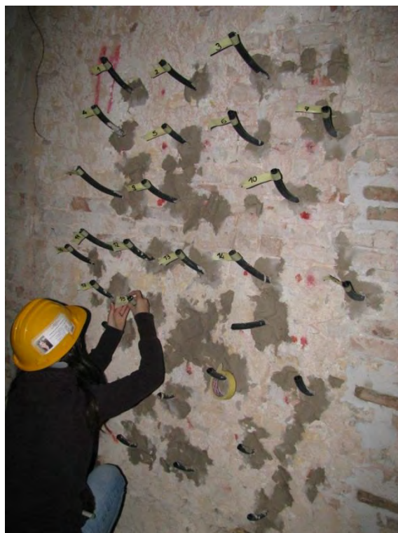
Fig. 2.4. 42 - Numerazione delle cannule (Museo Archeologico)
