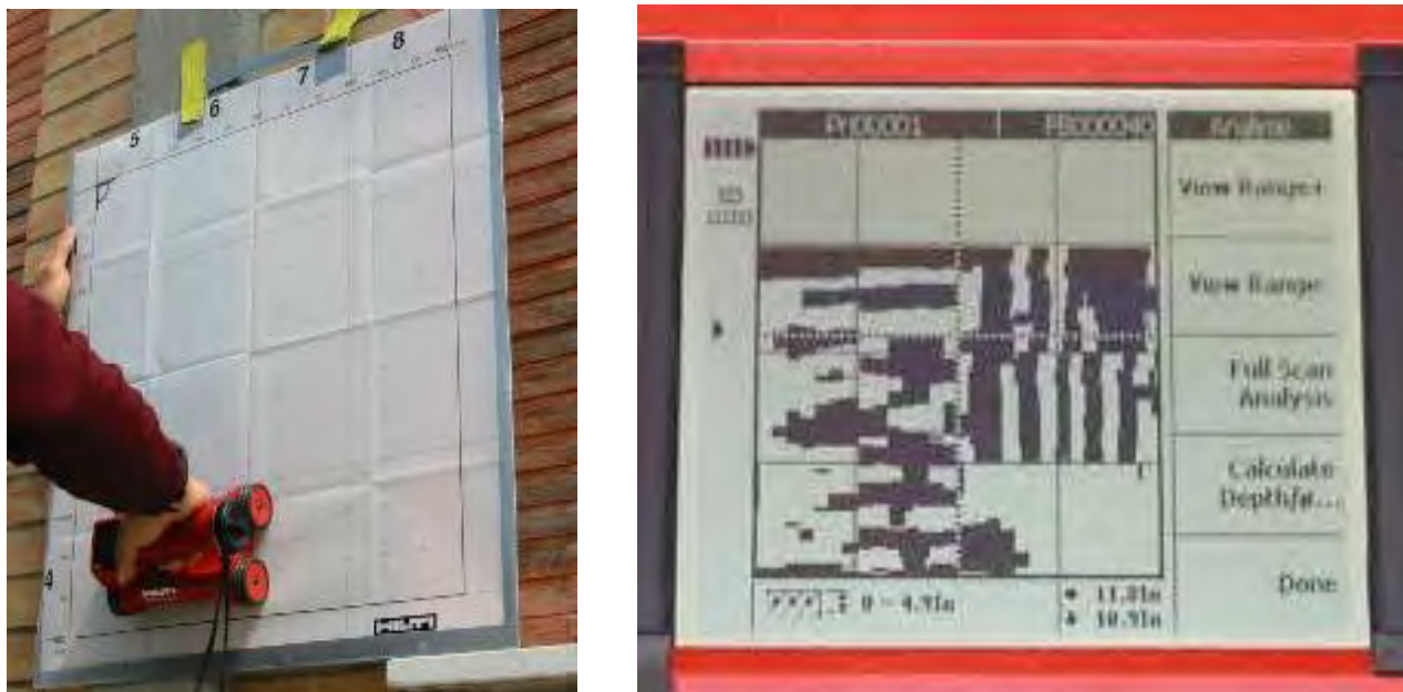
Fig. 1.1. 2 - Esecuzione della prova e relativi risultati (Giepi S.r.l.)
