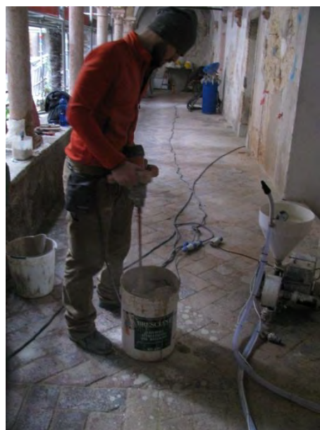
Fig. 2.4. 54 - Miscela Rofix e miscelazione mediante pompa ad immersione (Museo Archeologico)
