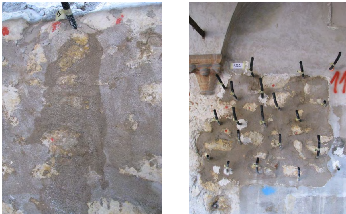
Fig. 2.4. 58 - Fuoriuscita d'acqua durante il lavaggio e ristilatura completa dei giunti (Campo prova 4
