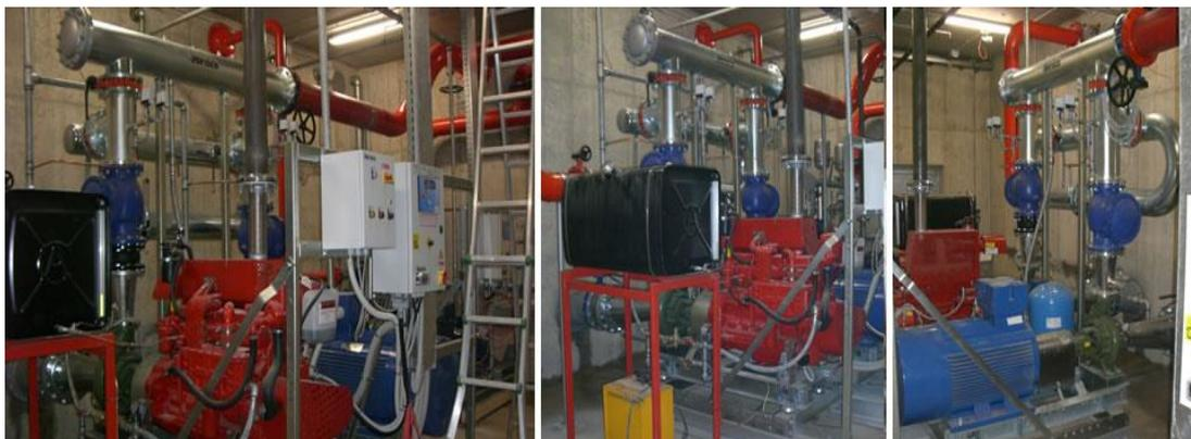
*Figura 3.7 – Esempio di applicazione motopompe Varisco S.p.A. nel settore sicurezza*
