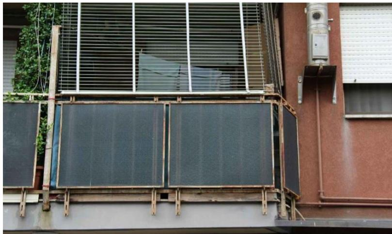
Figura 6.23 Degrado delle finiture. Fonte: Ater Padova.
