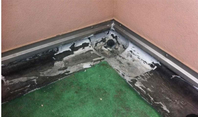
Figura 6.22 Degrado delle impermeabilizzazioni della copertura. Fonte: Ater Padova.
