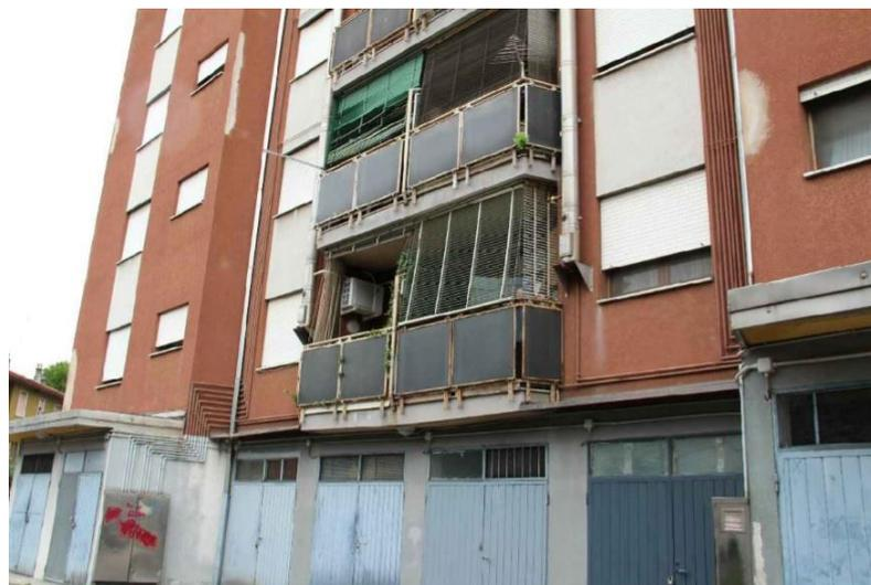
Figura 6.21 Degrado dei serramenti e dell'intonaco esterno. Fonte: Ater Padova.
