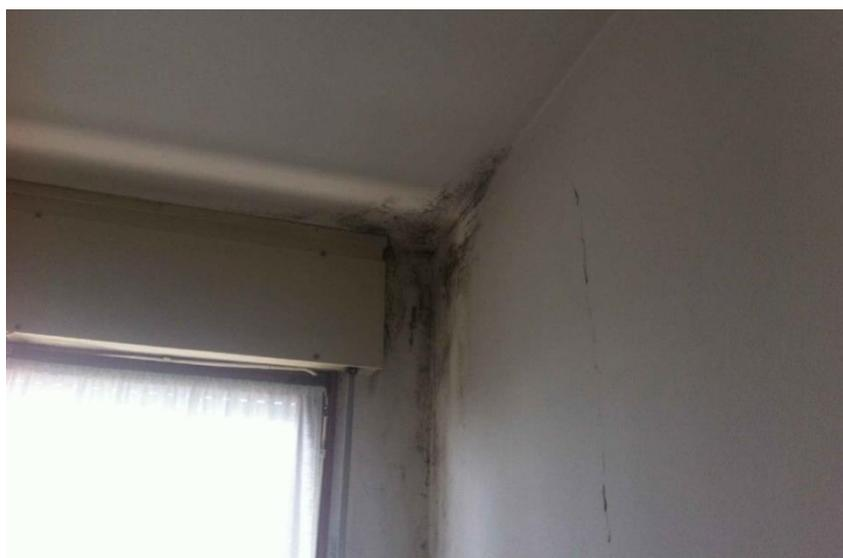
Figura 6.24 Degrado degli interni, presenza di umidità. Fonte: Ater Padova.
