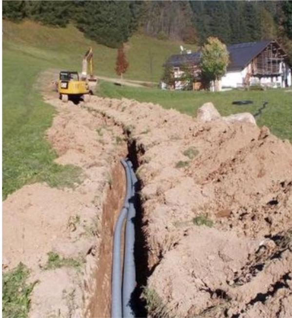
*Figura 2.17 - Scavi per interramento di una linea in cavo MT*
