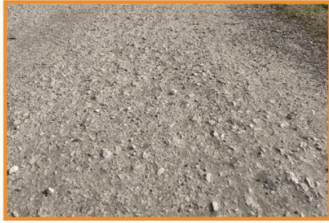
Figure 4.100: Gravel 2 surface tested, Lungargine del Piovego, Padova
