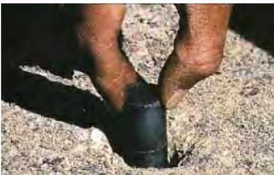
*Figura 1.3* Posizionamento dei magneti al centro della corsia ogni 1,2 metri per il controllo dello sterzo del veicolo (Bryant, 1997)
