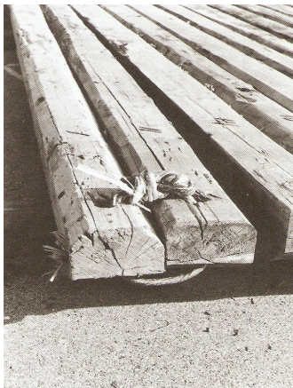
Figura 5.7 Nodo di testa (Cagnin et al., 1988)
