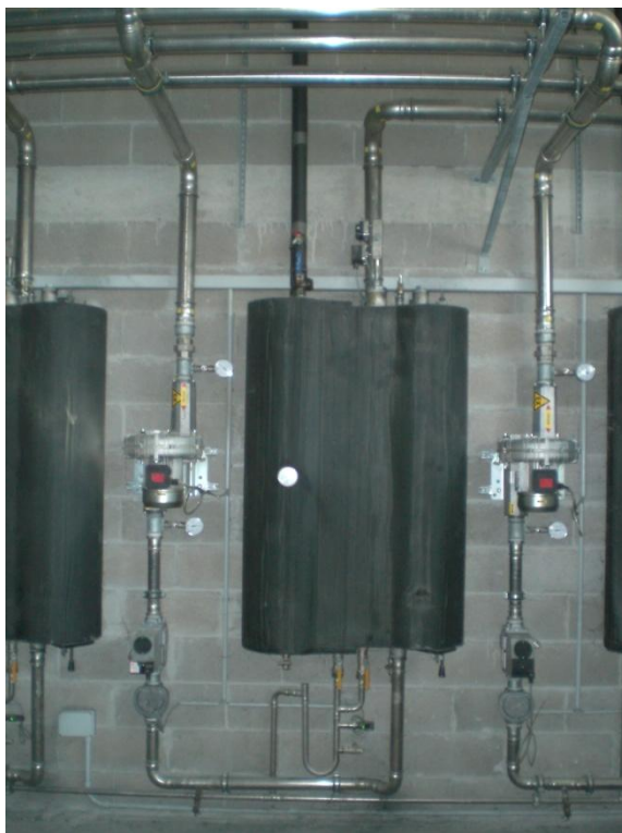
Figura 2.17. Fotografia di uno dei moduli GAM 120/180. Il gas entra dall'alto attraverso un tubo in acciaio ed esce dal basso per entrare nella soffiante, alla sinistra del pacco nero dove sono alloggiati gli scambiatori e i filtri.
