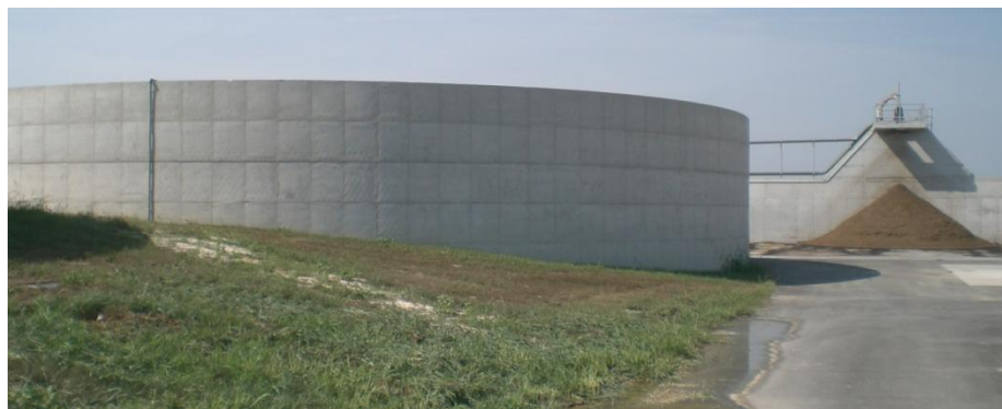
Figura 2.16. Fotografia di una della due lagune circolari per il separato liquido. In secondo piano, il separatore.
