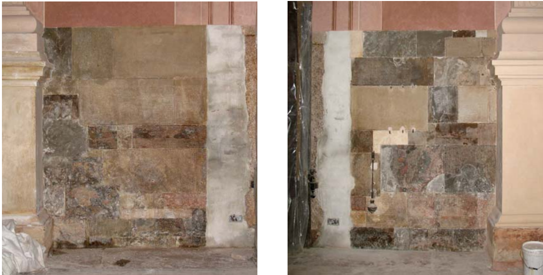
Figure 14 A e B. A muratura della controfacciata sul lato sinistro del portale; B muratura della controfacciata centrale sul lato destro del portale.
