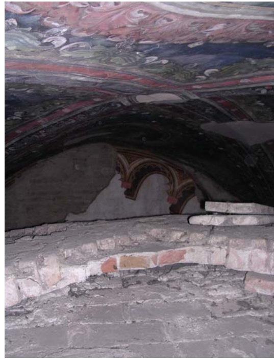
Figura 7, Vano con volta a crociera dipinta
