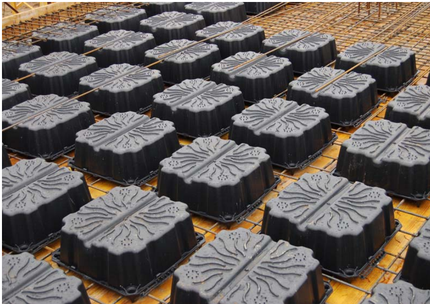
Figura 2.5. Posa elementi di alleggerimento
