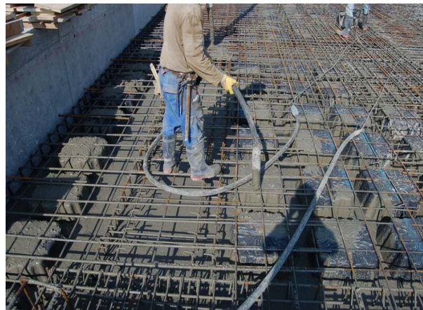
Figura 2.7. La vibratura
