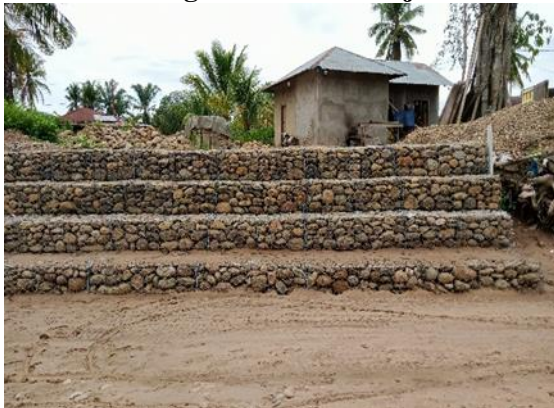
Gambar 1. Pembuatan Bronjong untuk Mitigasi Bencana Banjir
