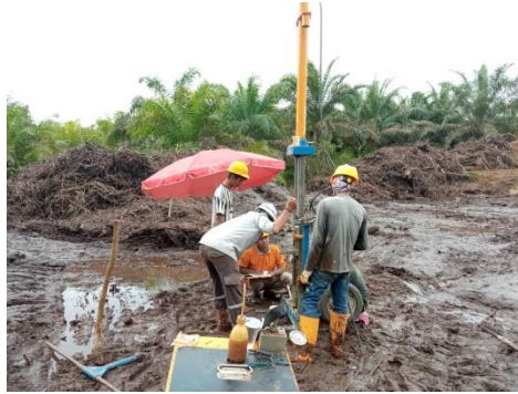
Gambar 3.16 Pengujian CBR Lapangan
