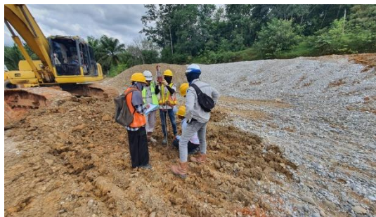
Gambar 3.25 Pengujian DCP
