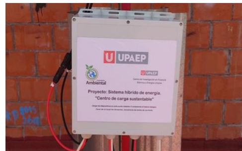
Gabinete del panel de control, fijado con tornillos a la estructura y cerrado con sello de silicón, a prueba de agua y polvo nivel IP-65
