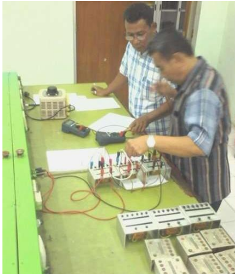
Gambar 4. Instalasi hardware dan Pengujian
