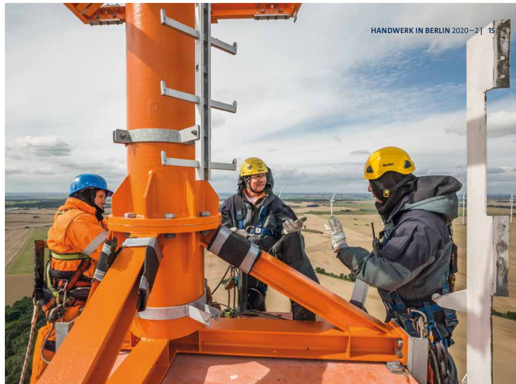
Spezialisten des Unternehmens Mastbau FN GmbH montieren Fernseh- und Rundfunk-Antennenanlagen. Seit 2019 ist der Betrieb zertifiziert.
