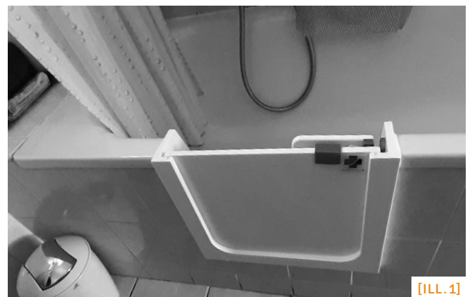
[ILL. 1] Première adaptation réalisée: pose d'un portillon dans la baignoire / Erste bauliche Anpassung: Einstiegs Luke Badewanne / Un primo adattamento realizzato: un portello per la vasca da bagno (Source: Pro Senectute Vaud)
