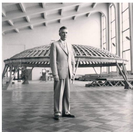
Slika 4. Autor konstrukcije Branko Željelić ispred modela kupole Hale 1 u Institutu IMS.
