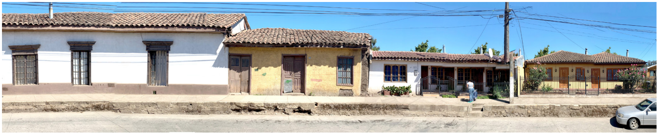
Figura 13. Fotografía de un sistema típico de agrupamiento continuo que se ha ido transformando progresivamente en paredado y aislado, Chanco, Chile (SEISMO, 2021).
