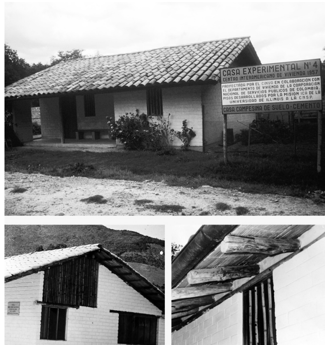
Figura 9. Vista general y detalles de la casa campesina de BTC o suelo-cemento construida en el patio de modelos del CINVA, al interior del campus de la Universidad Nacional de Colombia, Bogotá. (Fuente: Archivo Histórico de la Universidad Nacional de Colombia, fondo CINVA, caja 134).
