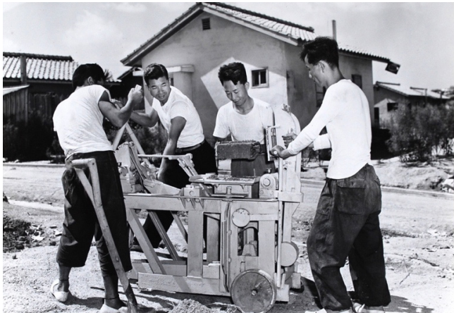
Figura 1. Máquinas compactadoras marca Landcrete empleadas por UNKRA en la reconstrucción de Corea del Sur, 1958. (Fuente: Archivo ONU Ref. S-0526-0168-0002-00008).
