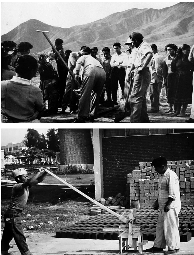
Figura 6. Demostraciones de los usos de la máquina Cinva-Ram en el Perú. (Fuente: Archivo Histórico de la Universidad Nacional de Colombia, fondo CINVA, caja 208).
