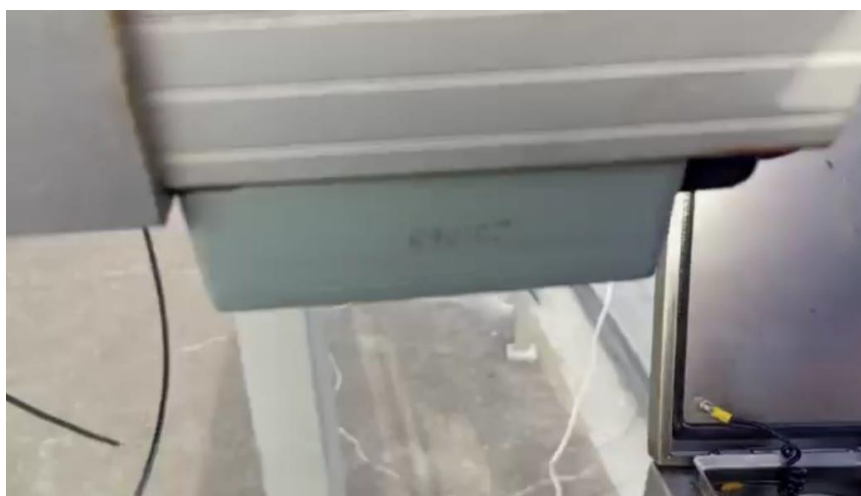
Figura 5.9: Instalación del sensor de posición.
