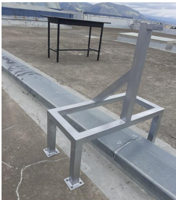
Figura 5.10: Soporte del actuador.
