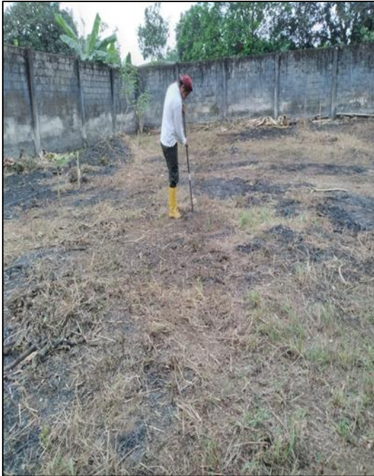
Fotografía 1. Limpieza del terreno
