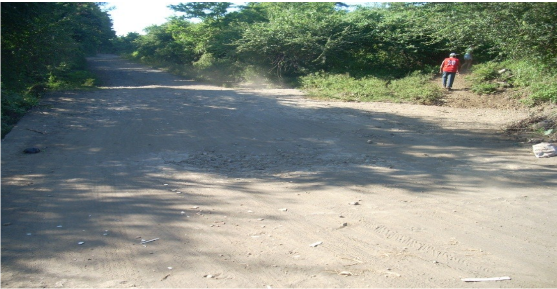
Fuente: Obra de drenaje del proyecto. Alcaldía de León.
