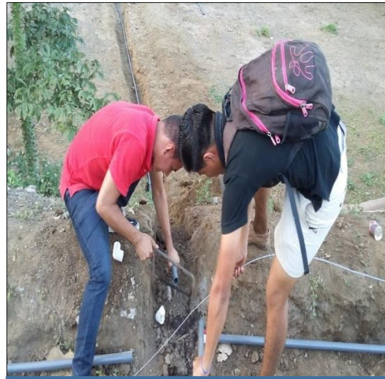
Foto 4: Instalación de las tuberías
