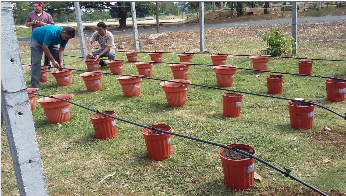
Foto 5: Instalación de los goteros en los laterales de riego
