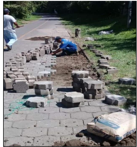
Imagen 4: Mantenimiento del Adoquinado
