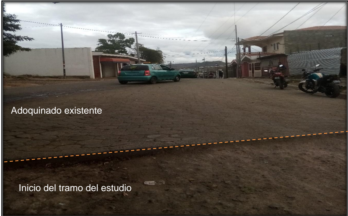
Foto 1. Inicio del tramo, Adoquinado Existente (Est. 0+000).
