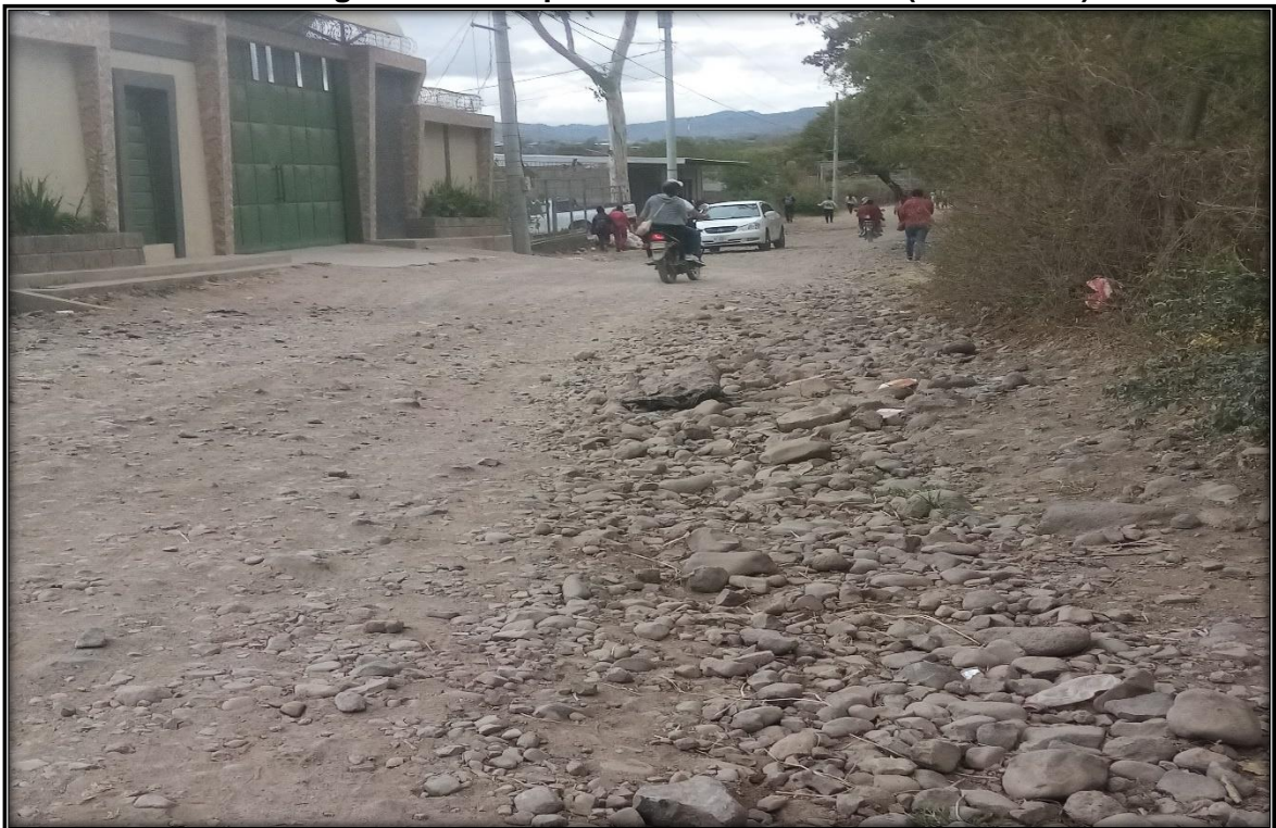
Foto 6. Desgaste en la superficie de Rodamiento (Est. 0+358).
